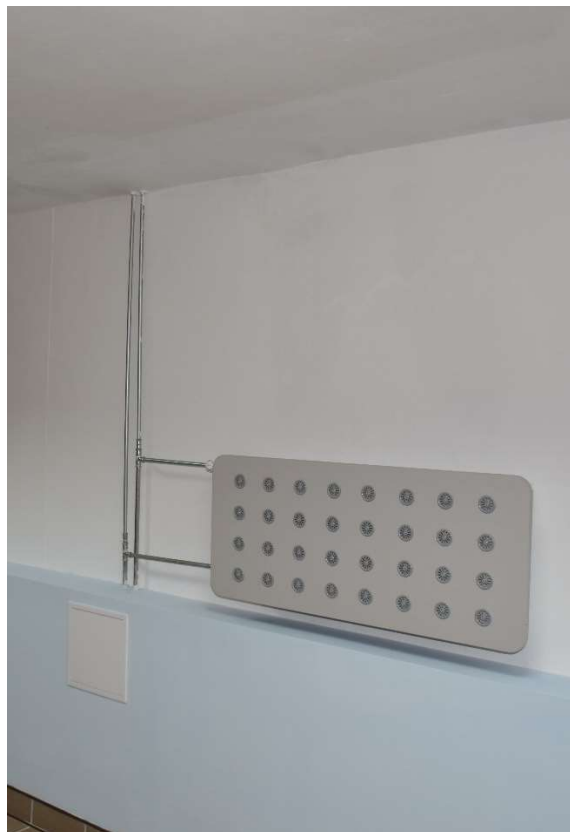
Fot. 6 Piony instalacji centralnego ogrzewania podlegające zabudowie
