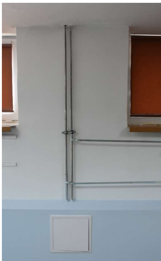
Fot. 6 Piony instalacji centralnego ogrzewania podlegające zabudowie
