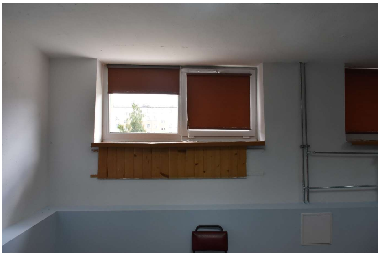
Fot. 8 Okno – parapety powlekane podlegające wymianie, boazeria do demontażu
