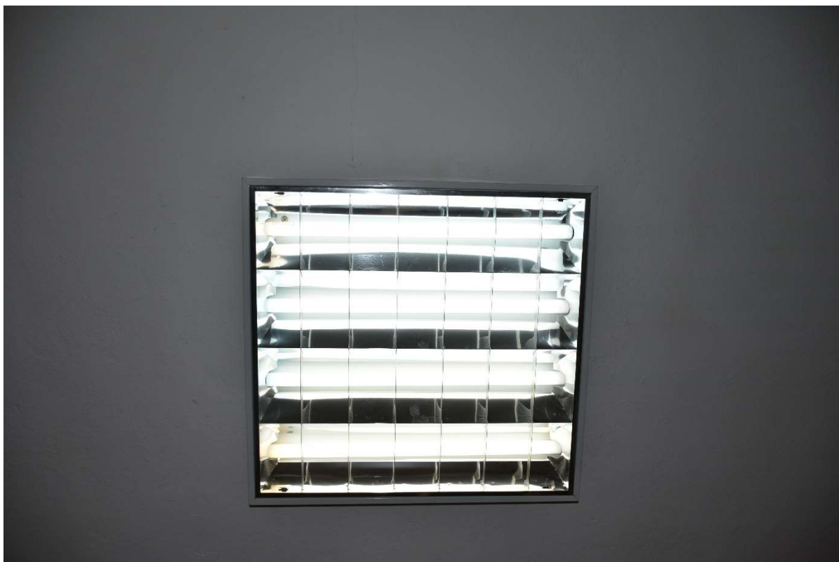
Fot. 9 Oświetlenie pomieszczenia – oprawy rastrowe natynkowe pod świetlówkę
