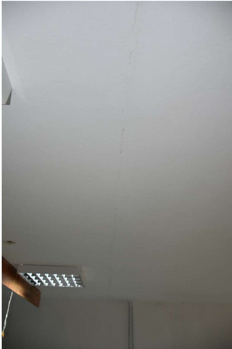
Fot. 11 Rysa podłużna na stropie pomieszczenia
