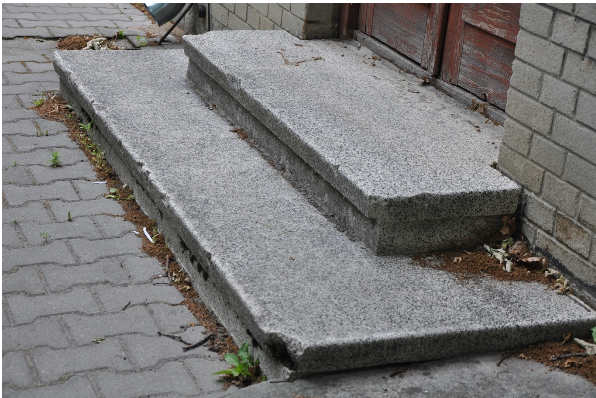
Fot. nr 23 – Budynek B – zniszczenia podestu z lastriko przy drzwiach bocznych.
