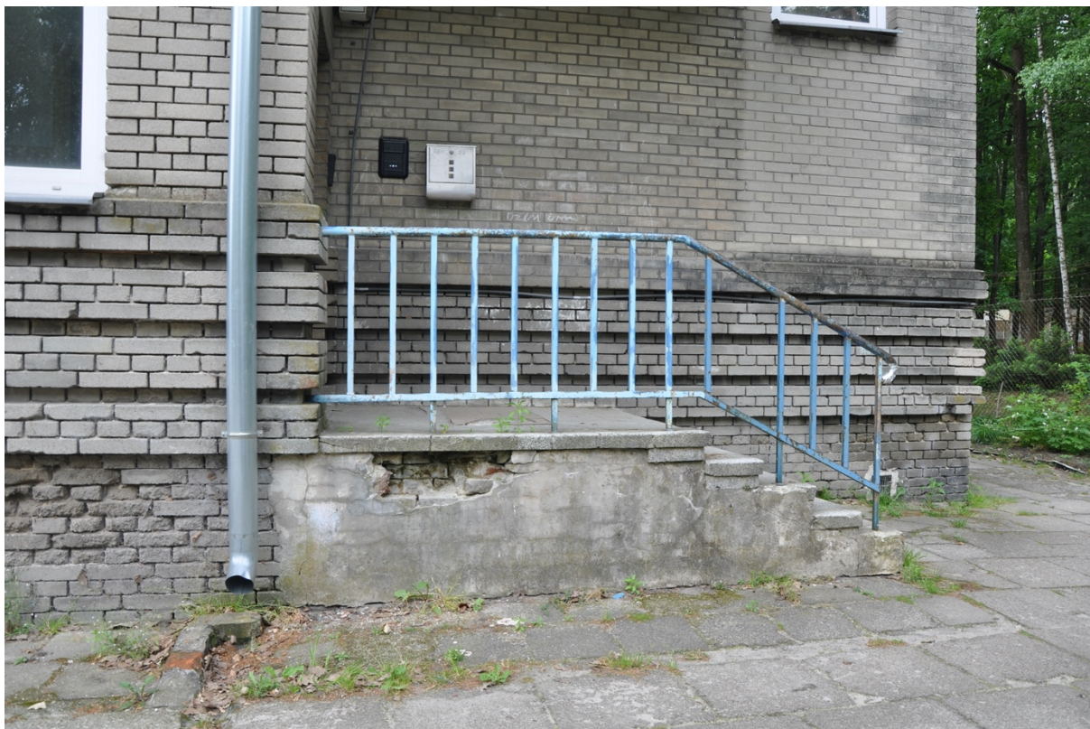
Fot. nr 15 – Budynek B – zniszczenia partii cokołowej.
