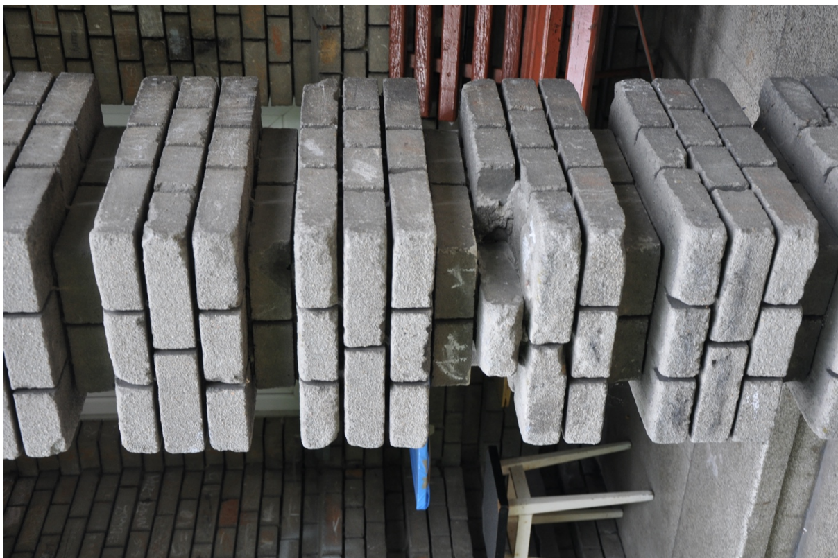
Fot. nr 7– Budynek B – zniszczenia słupów przy klatce schodowej.
