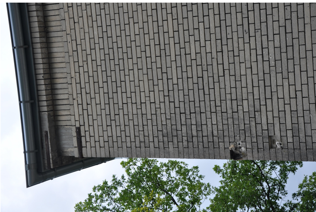
Fot. nr 17 – Budynek B – ubytki cegły w elewacji.
