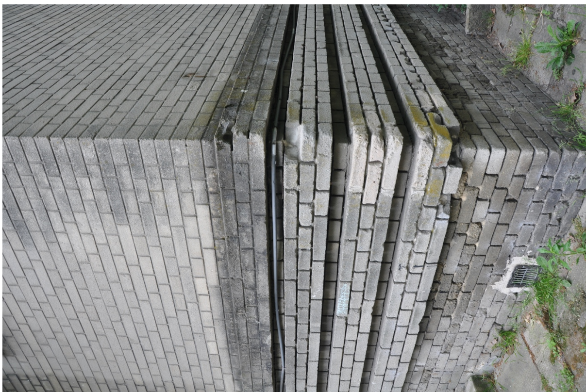
Fot. nr 12 – Budynek B – zniszczenia partii cokołowej.
