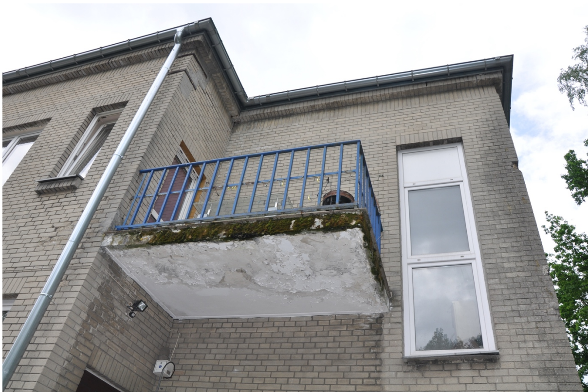
Fot. nr 13 – Budynek B – zniszczenia tarasu ( balkonu).
