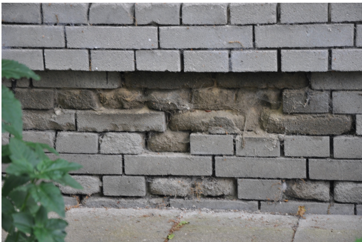
Fot. nr 20 – Budynek B – zniszczenia partii cokołowej.
