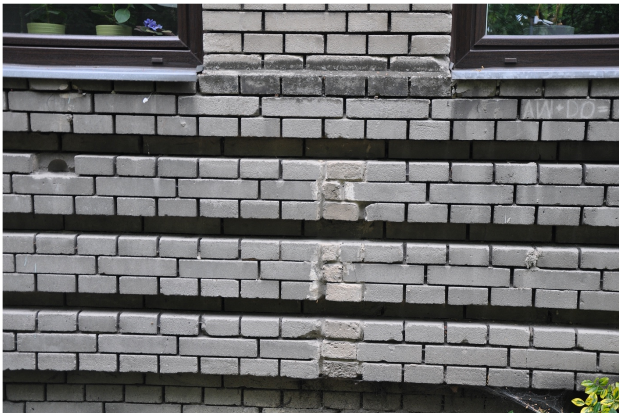
Fot. nr 5 – Budynek B – zniszczenia partii cokołowej.
