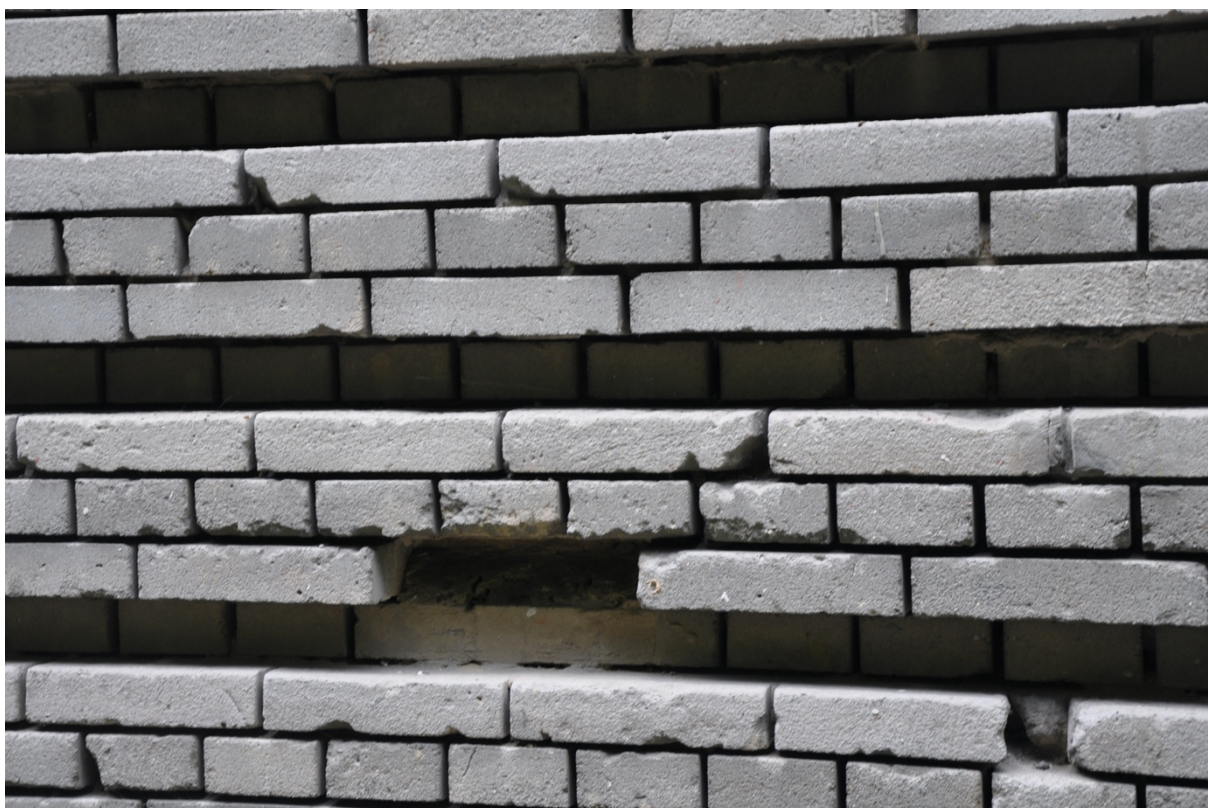
Fot. nr 28 – Budynek A – zniszczenia partii cokołowej.
