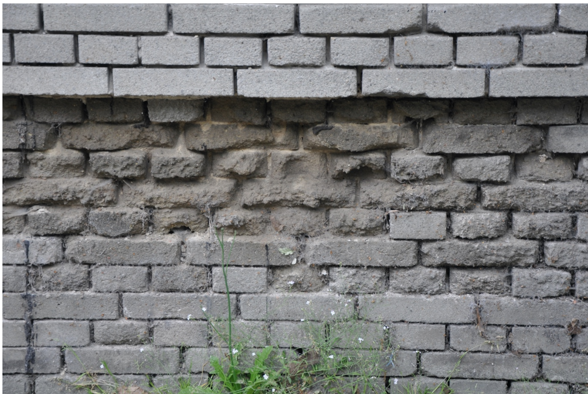
Fot. nr 16 – Budynek B – zniszczenia partii cokołowej.
