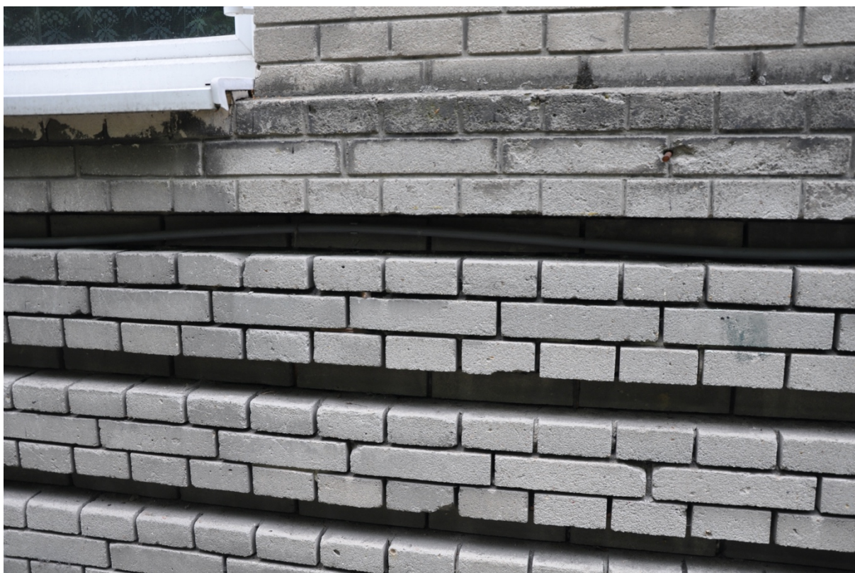
Fot. nr 10 – Budynek B – zniszczenia partii cokołowej.
