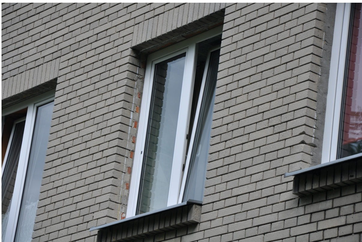
Fot. nr 26 – Budynek A – źle wstawione nowe okna.
