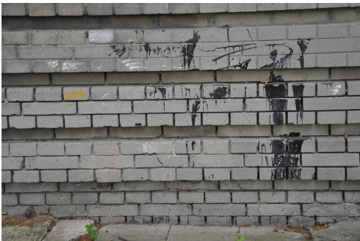
Fot. nr 22 – Budynek B – zniszczenia partii cokołowej -zachłapania smołą.
