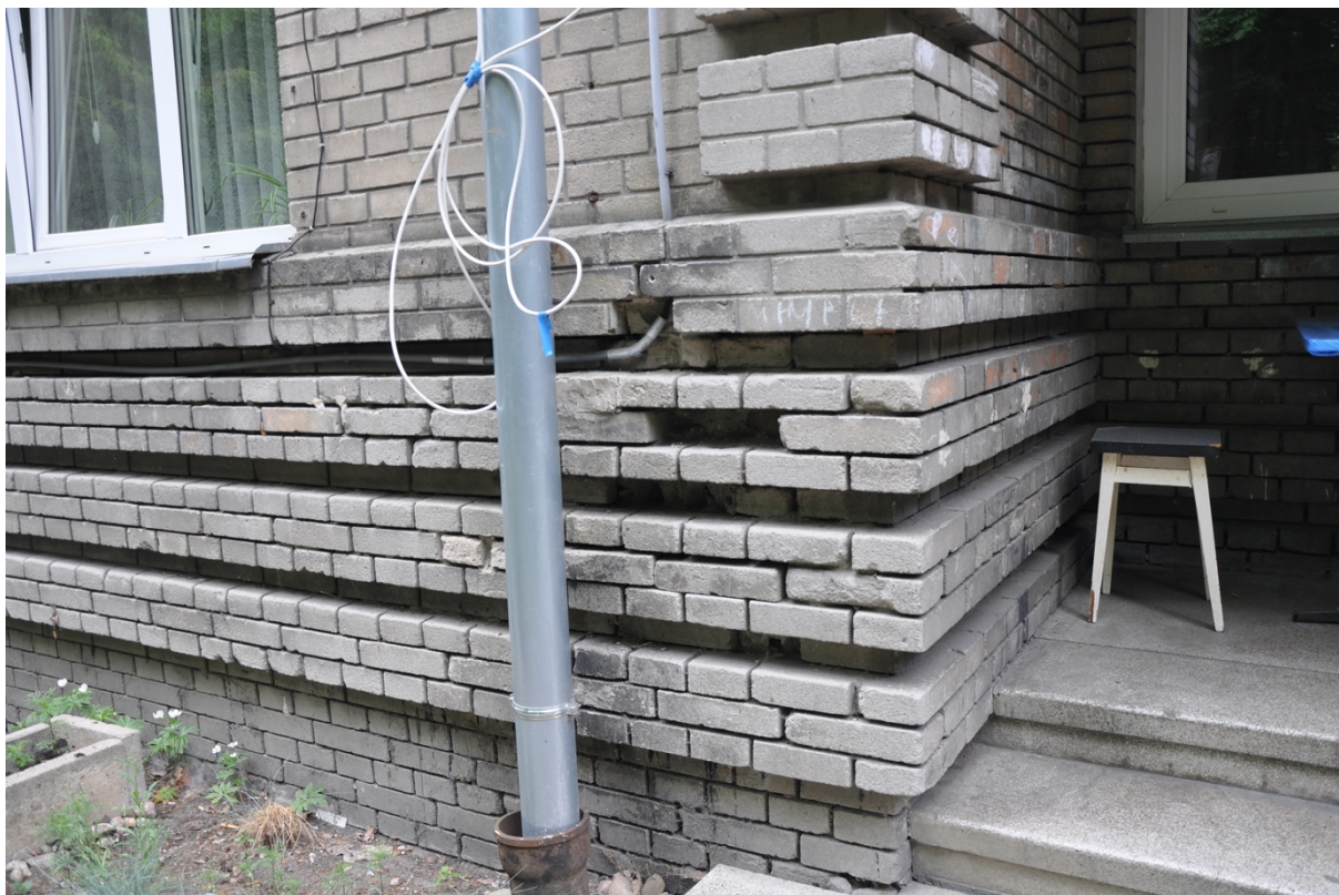
Fot. nr 9 – Budynek B – zniszczenia partii cokołowej.
