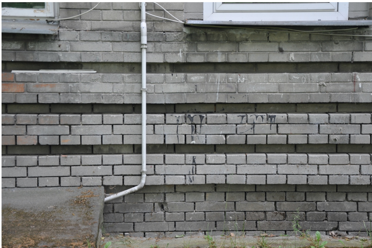
Fot. nr 21 – Budynek B – zniszczenia partii cokołowej – zachłapania smołą.
