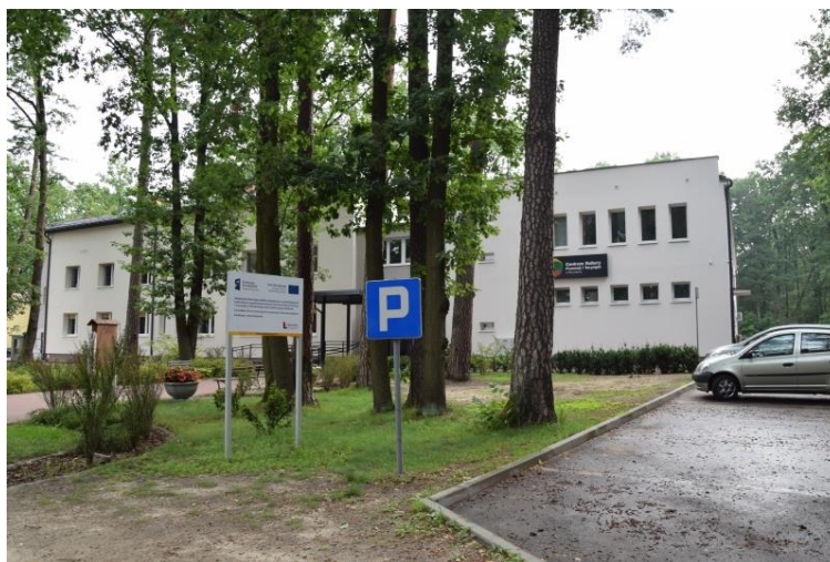
Foto 4 Budynek CKPiT i Biblioteki
