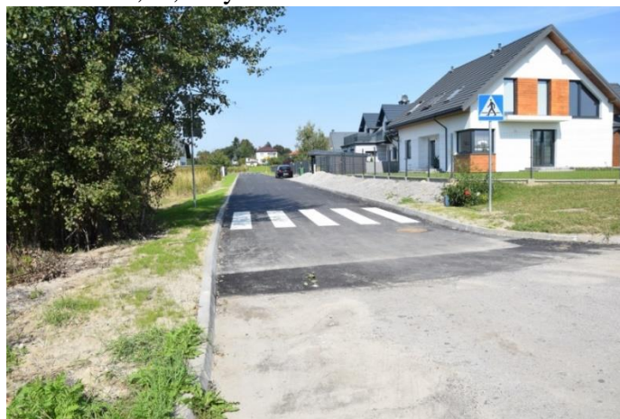
Foto 2 Budowa ulicy w ramach Rządowego Funduszu Rozwoju Dróg
