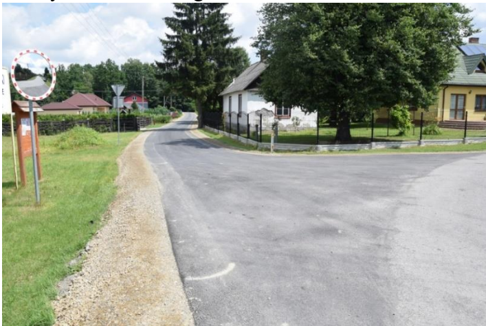
Foto 1 Budowa dróg w ramach Rządowego Funduszu Rozwoju Dróg
