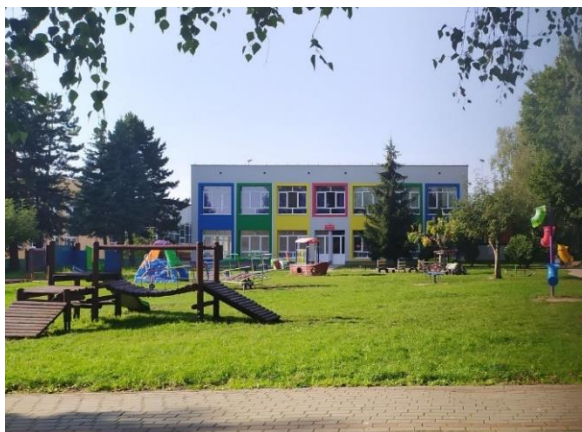
Foto 3 Termomodernizacja Przedszkola Miejskiego
