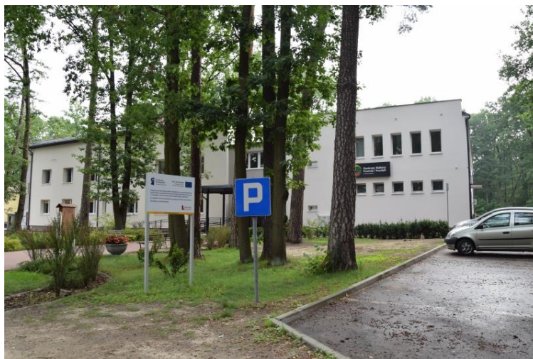
Foto 1 Budynek CKPiT i Biblioteki
